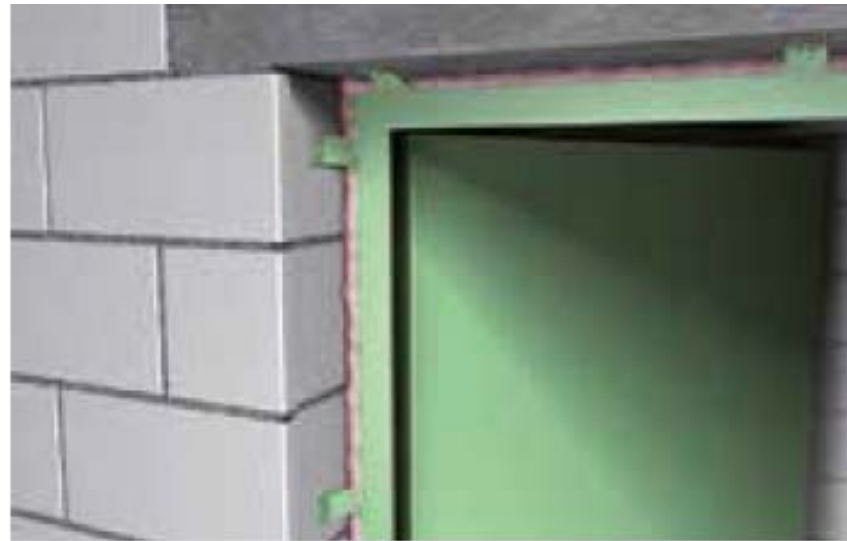
Riempimento di telai di porte
