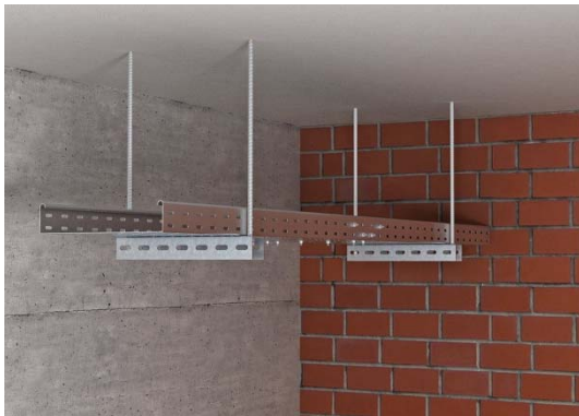
Installazione a soffitto con barre filettate
