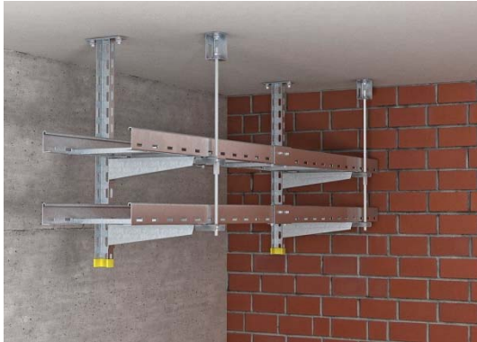
Installazione a soffitto
