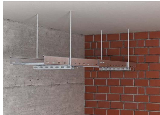
Installazione a soffitto con barre filettate
